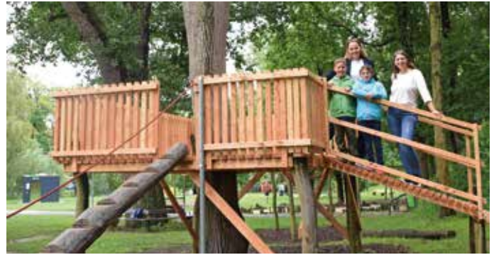
Mario und Ina Marischka überprüfen bereits die neue Aussichtsplattform am Spielplatz im Horner Stadtpark.
