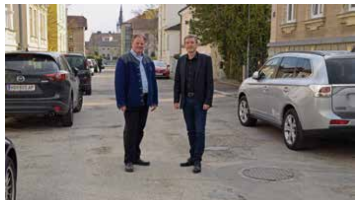
Vor der Sanierung: StR Manfred Daniel und Bgm. Jürgen Maier beim Lokalaugenschein in der Schulgasse.
