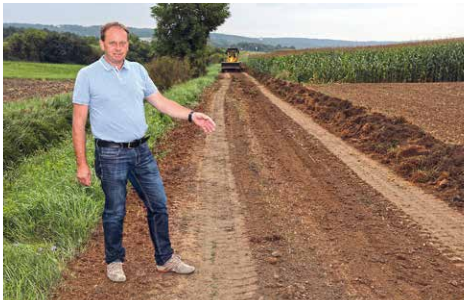
Die Sanierungsarbeiten waren teilweise aufwändig - wie hier in Breiteneich am Weg zur Tegelgrube.
