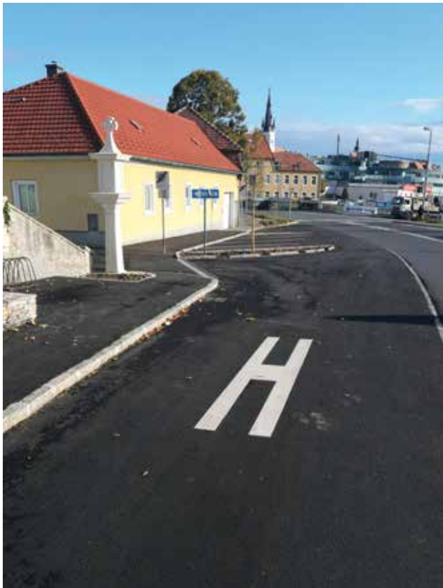
Der neu gestaltete Parkplatz am Beginn der Prager Straße
