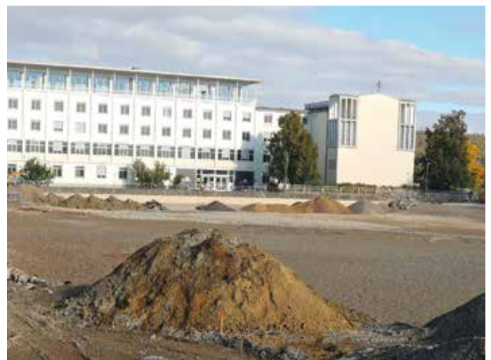
Die Arbeiten für das Erholungszentrum „Stadtsee Horn“ haben bereits begonnen.
