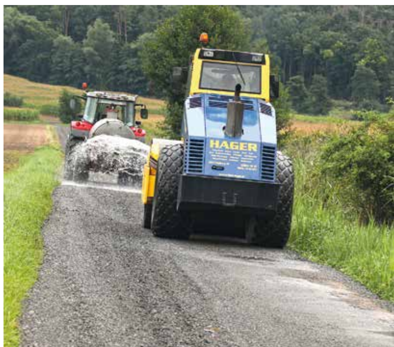
Die Walze der Firma Hager war tagelang im Einsatz - hier in Breitenreich am Breitenwiesenweg
