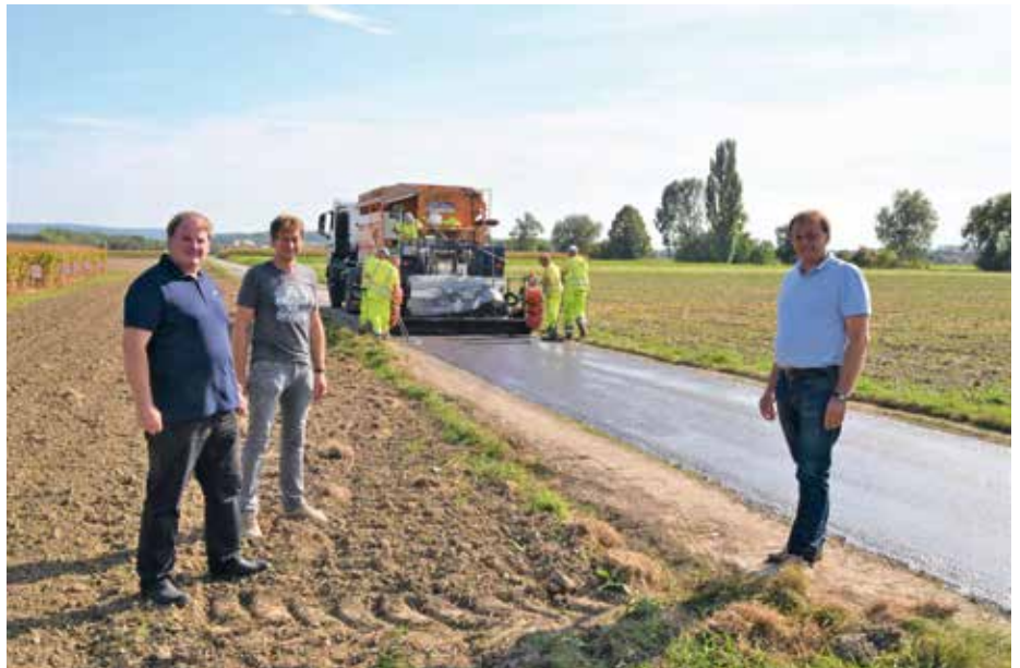
Sanierung Altbachweg: StR Manfred Daniel, Wirtschaftshof-Leiter Johannes Kapitan und Ortsvosther GR Robert Lochner überzeugten sich vom Baufortschritt.
