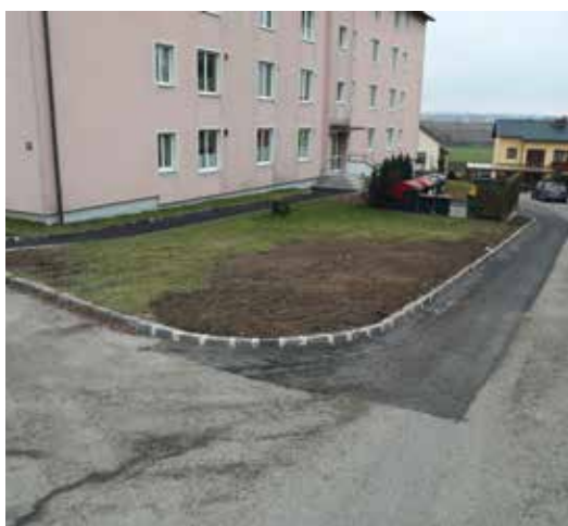
Zugang und Straßenverbreiterung nach der Fertigstellung
