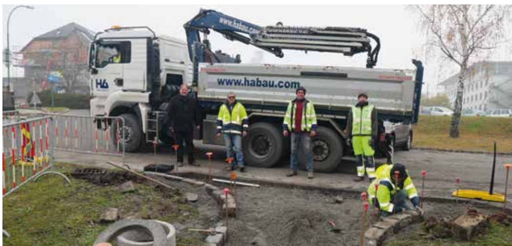
Im Zuge des Umbaus wurden auch gleich die Kantensteine an den Zugangswegen und der Straße von der Firma Habau neu verlegt - am Bild StR Manfred Daniel mit den Mitarbeitern der Firma HABAU.
