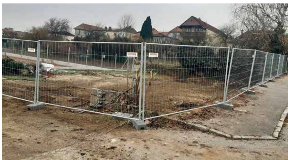
Dem Erdboden gleich gemacht wurde das alte Clubhaus des Tennisvereins. Nun kann der Bau des neuen Vereinsgebäudes starten.
