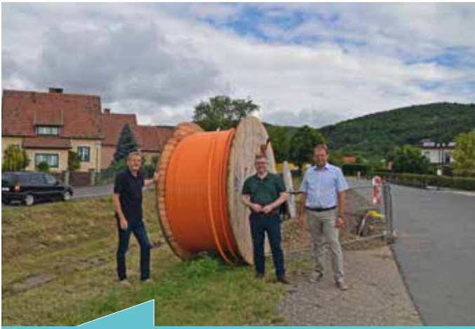
LABg. Bürgermeister Jürgen Maier, Landesrat Ludwig Schleritzko und Ortsvorsteher Robert Lochner bei der Begehung der Baustelle.
