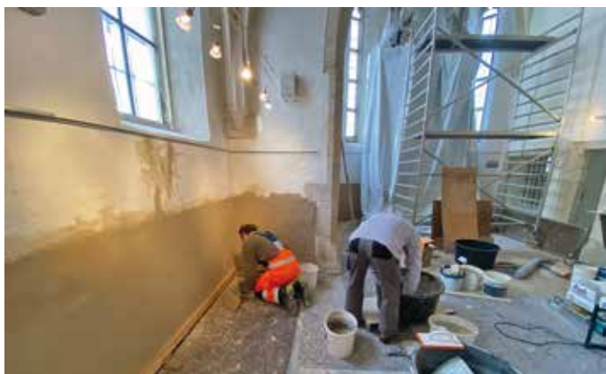
In der Bürgerspitalkapelle renovieren die Mitarbeiter des Wirtschaftshofes die alten Mauern. Der kaputte Putz wurde abgeschlagen, danach wurde frisch verputzt und angemalt.
