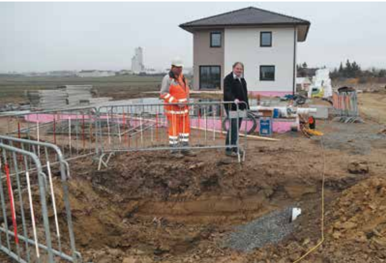
StR Manfred Daniel beim Lokalausgleich mit Polier Josef Zehetner (Fa. Leyrer+Graf) in der Franz-Pareis-Straße - vorne der neu verlegte Kanal, hinten ein neues Einfamilienhaus
