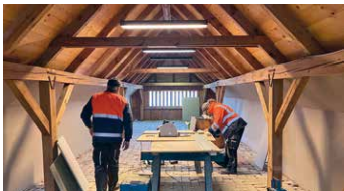
Bauhofmitarbeiter bei ihren Arbeiten im Museum
