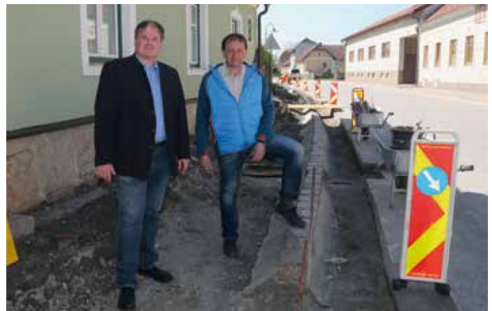
StR Manfred Daniel und Ortsvorsteher GR Robert Lochner überzeugen sich am 14. April 2022 vom Baufortschritt in Mödring.
