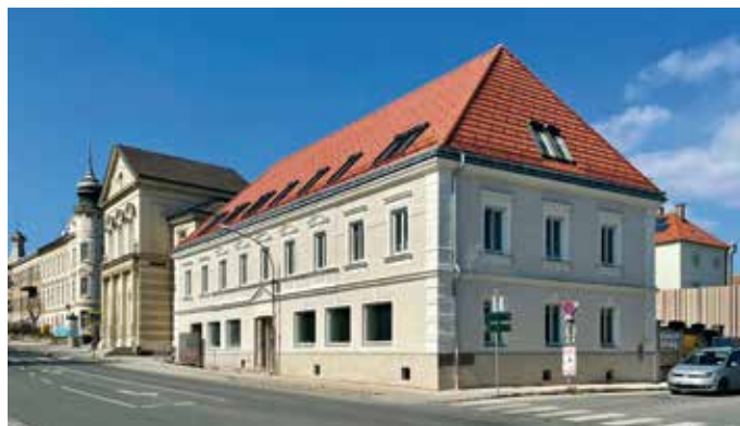
Das „Ibesich-Haus“ nach der Renovierung
