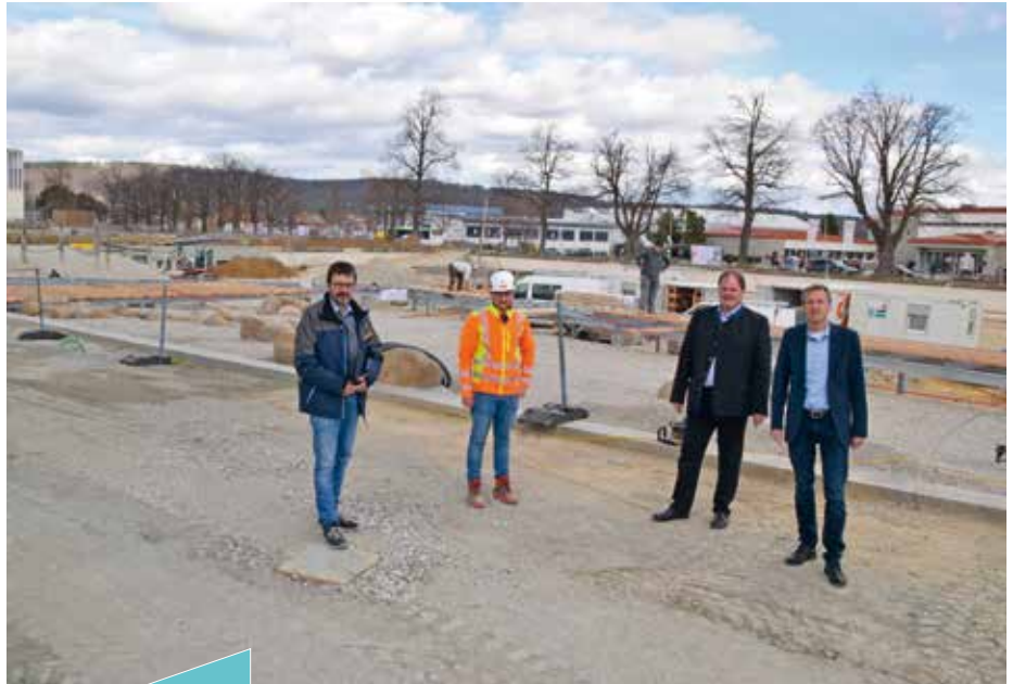
Den Überblick hat Leyrer+Graf Bauleiter Mathias Schwarzinger, der Vizebürgermeister Gerhard Lentschig, Baustadtrat Manfred Daniel und Bürgermeister LAbg. Jürgen Maier durch die Baustelle führt.
