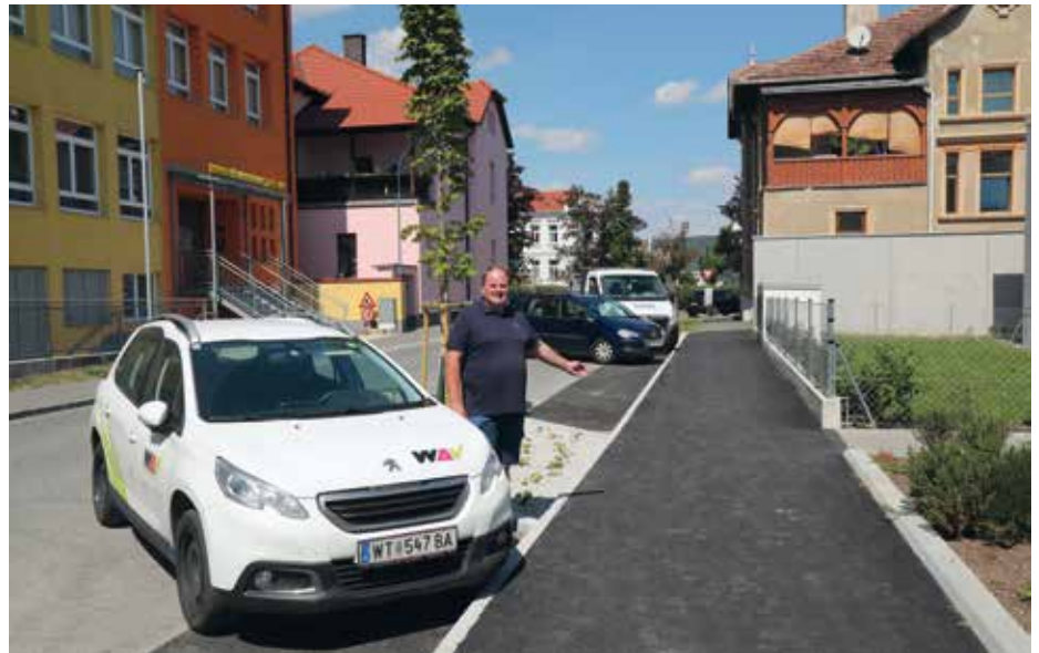
Schulgasse: Der neue Gehweg und die Schrägparkplätze mit den begrünten Bauminseln
