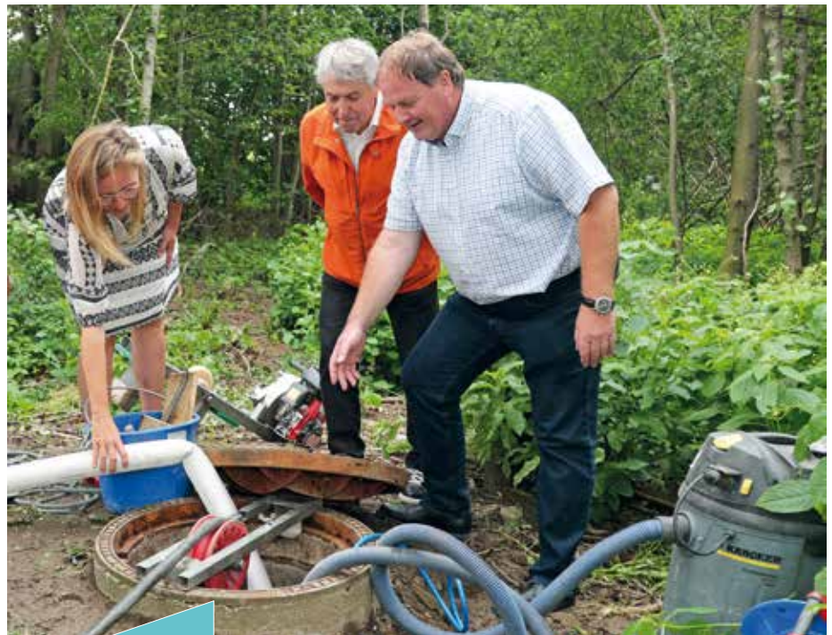
Bgm. Gabi Kernstock „überprüft“ zusammen mit DI Johann Steinbacher und StR Manfred Daniel den Luftdruck, der den „Inliner“ an die Kanalwände presst.
