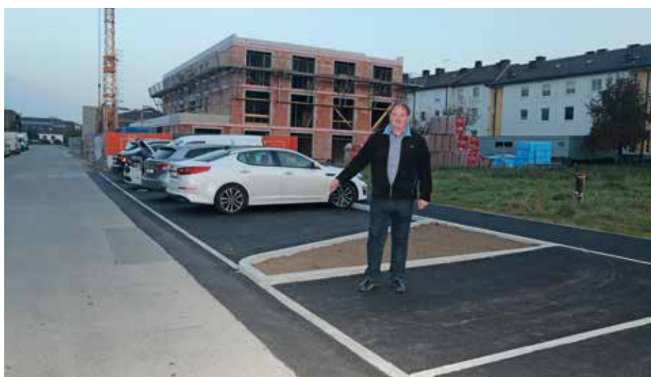
Stadtrat Manfred Daniel zeigt die ersten fertigen Parkplätze, dahinter der Rohbau des Wohnprojektes, rechts der Garten, der demnächst - barrierefrei - angelegt wird.
