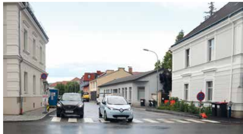
Spitalgasse: Weniger Rückstau durch die zweite Abbiegespur, die durch die Verbreiterung der Straße möglich wurde.
