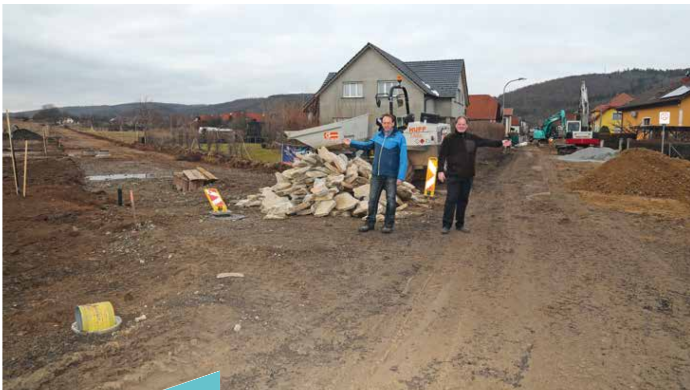
Ortsvorsteher GR Robert Lochner (li.) zeigt auf die neue Siedlungsstraße, Baustadtrat Manfred Daniel auf die Straße „Steig“, in der Wasserleitungen, Kanalstränge erneuert und Glasfaserkabel verlegt wurden.
