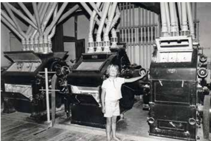
Walzenstühle in der Rasch-Mühle
