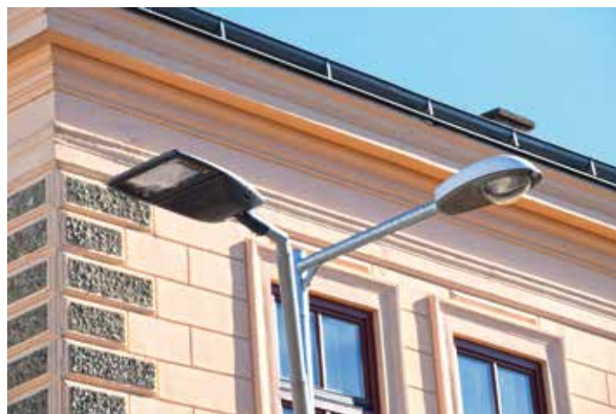
Alte und neue Beleuchtungstechnik auf einem Mast zusammen: Die Zebrastreifen im Bereich der Schulen werden bereits mit LED beleuchtet.
