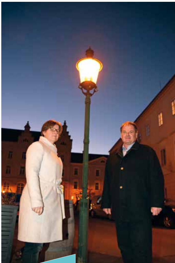
Mit der Übernahme des Umweltressorts ist nun StR Isabel Mang für nachhaltige, umweltschonende Maßnahmen sowie auch für die öffentliche Beleuchtung zuständig. Gemeinsam mit Verkehrsstadtrat Manfred Daniel wird die neue Straßenbeleuchtung beschlossen.
