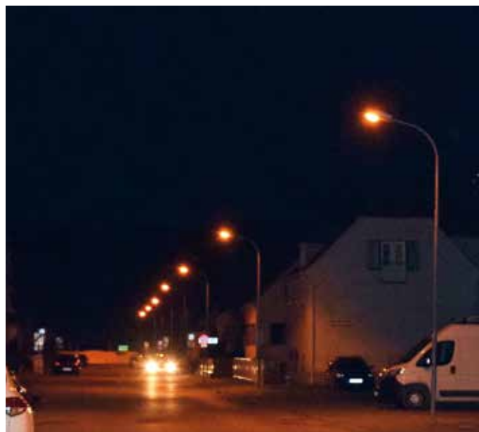
Einige Straßenzüge werden bereits mit LED-Technik beleuchtet. Hier in der Spitalgasse wird demnächst umgerüstet.
