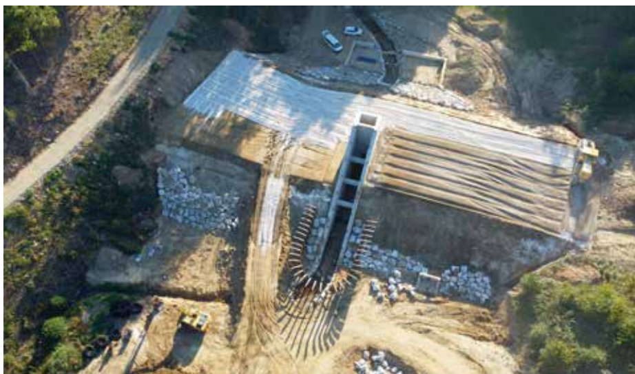
Blick von oben auf das Baufeld (Drohnenfoto)
