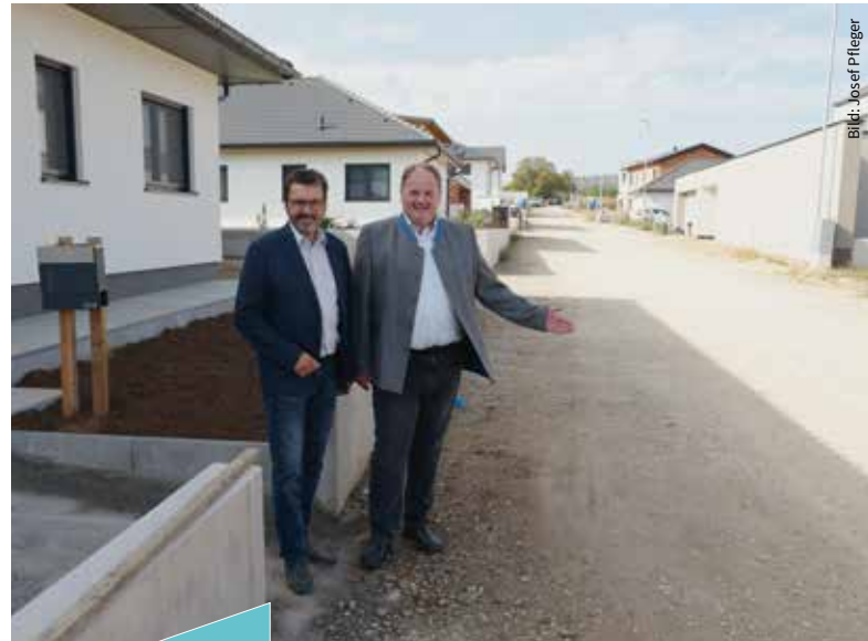
Bürgermeister Gerhard Lentschig und Baustadtrat Manfred Daniel besuchten Anfang Oktober die Straßenbaustelle in Mödring
