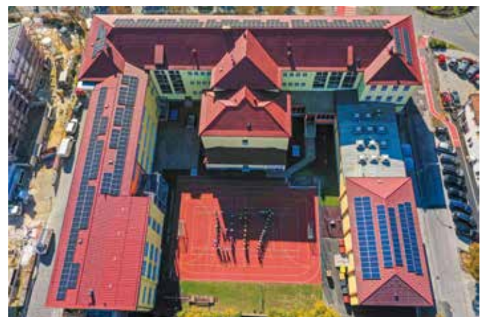
Die PV Anlagen auf den Dächern der Mittelschule Horn
