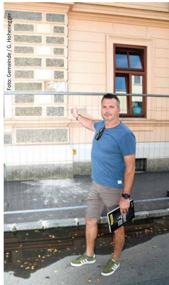
Thomas Bauer-Pöll, Technischer Gebäudeverwalter der Stadtgemeinde Horn, zeigt hier die Stelle, wo sich die Verputzplatte gelöst hat.
