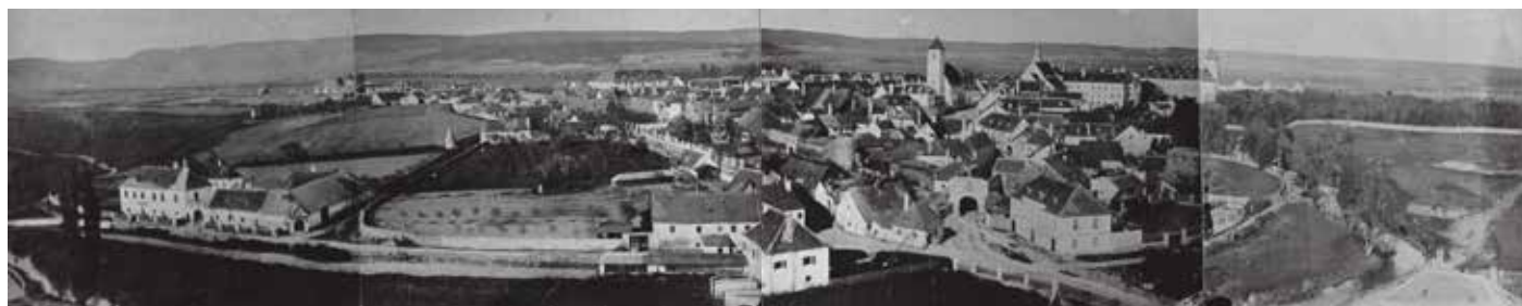
Das Foto von 1866 – eines der ältesten im Stadtarchiv – zeigt die Stadt Horn von Süden, vom Karglhof an der Frauenhofner Straße im Westen bis zum Schloß- und Naturpark im Osten. Das Prager Tor wurde 1895 abgetragen, der Turm der Georgskirche erhielt schon 1880 eine neue, außerordentliche hohe Haube.
