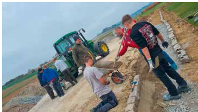
Gemeinsam mit Bau-Fachbereichsleiter Clemens Fehrle haben zehn Schüler beim Sportverein St. Bernhard am Fußballplatz Randsteine für den Trainingsplatz gesetzt.
