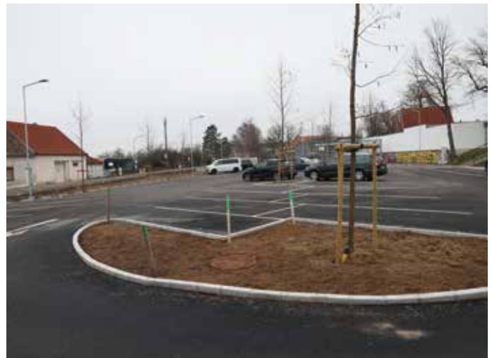
Der fertige Stadtseeparkplatz mit den schwammstadttauglichen Bäumen
