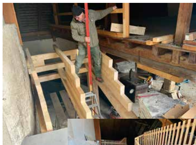
Holzstiege im Bau und fertiggestellt
