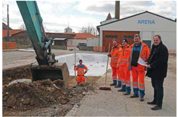
Umfangreiche Bauarbeiten waren für die Baumpflanzung notwendig.
