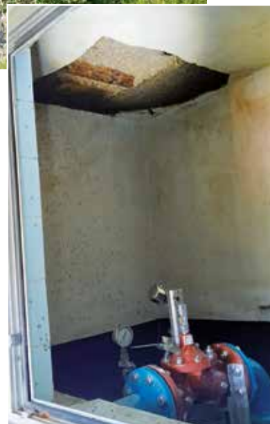
Einbruch der Decke
