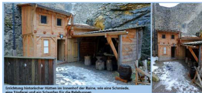
Errichtung historischer Hütten im Innenhof der Ruine, wie eine Schmiede, eine Töpferei und ein Schuppen für die Belebungen
