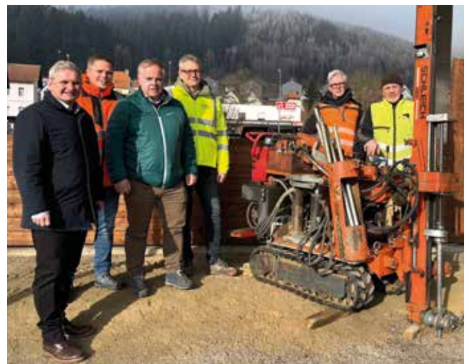
Begutachtung der ersten erfolgreichen Probebohrungen und Bodenschürfungsarbeiten am Roßdorfplatz.
