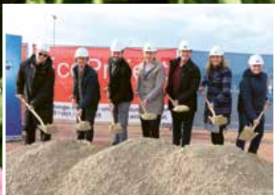
Kindergarten Badgasse in Bau
