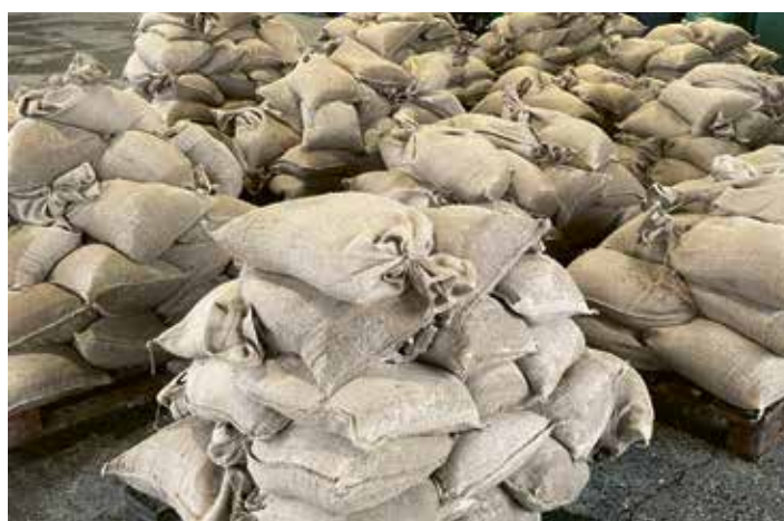
Am Wirtschaftshof der Stadtgemeinde wurden „im Akkord“ mehrere Tonnen Sand in Säcke verpackt, um dann zur Bewehrung des Dammes aufgestapelt zu werden. Insgesamt über 2000...
