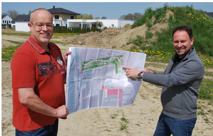
Gemeinsam überzeugen sich Bürgermeister Dr. Hochhold und Familienausschussobmann Winter vom Fortschritt der Bauarbeiten im Grünzug. Rechts oben im Bagger: „Landschaftsformer“ Herbert Gast
