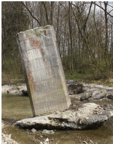
Der Mittelpfeiler samt Fundament ...
