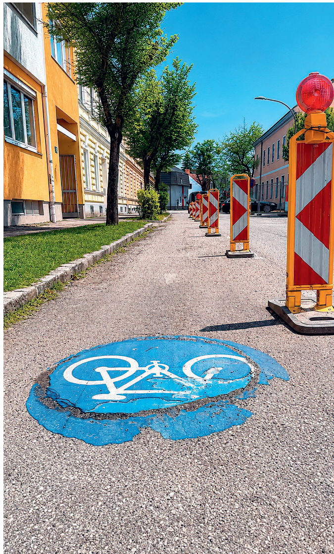
Korneuburg baut: Baustellen im Sommer.
