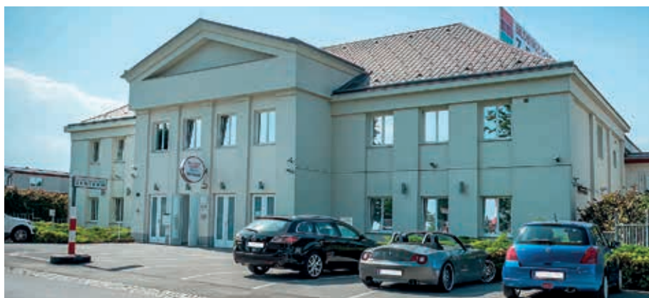
Asylquartier: Außenansicht des Gebäudes in der Raiffeisenstraße 4.
