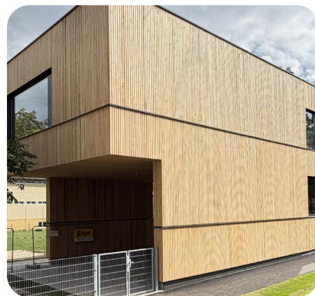
Foto: Architekt Max Schmied, SLP ARCHITEKTEN ZT GmbH | Der neu errichtete Hortzubau
