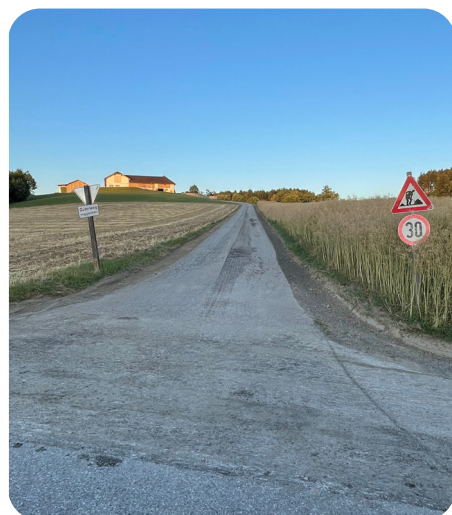
Sanierung des Güterweges Voggeneder in Selker
