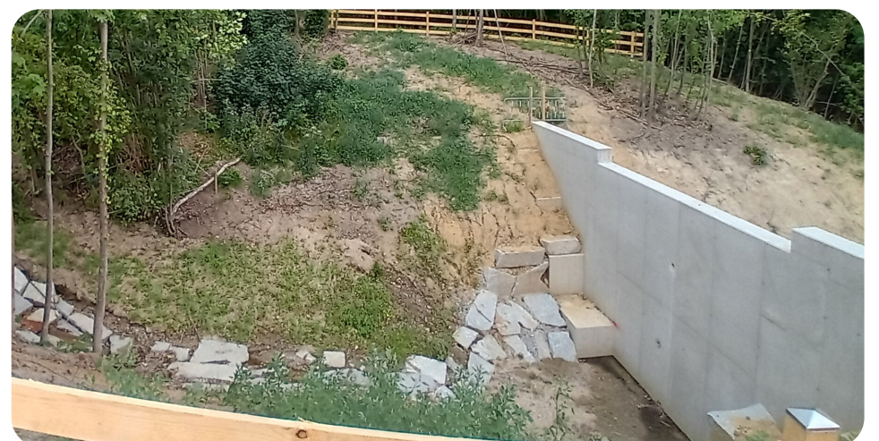
Das neu errichtete Rückhaltebecken in Sandleiten. | Foto: Samuel Wallner
