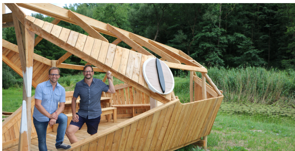
Initiator Fritz Robeischl und Projektleiter Hermann Leberbauer beim Bau des Schlangenkopfes beim Biotop Fuchsschweif. Das Projekt wurde mit dem Bildhauernetzwerk "Wüdwux" und freiwilligen Helfern umgesetzt.
