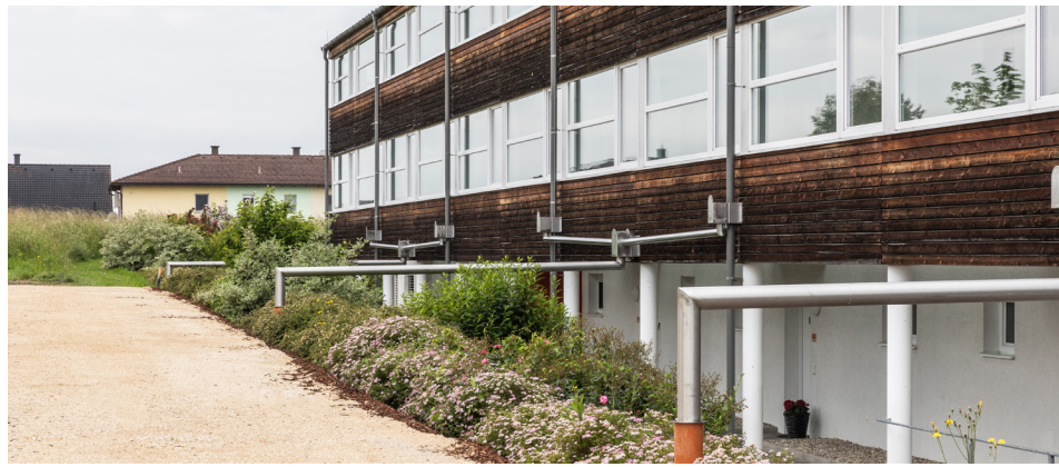
Das Dachwasser des Nachbargebäudes bewässert die Klimainsel, stärkt den Grundwasserspiegel und entlastet den Ortskanal.
