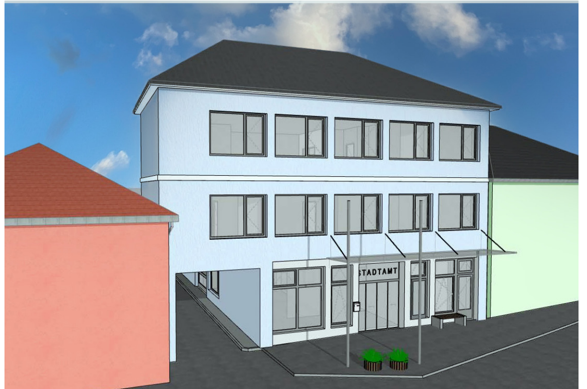
2026 wird das Stadtamt um rund 450.000 Euro saniert. Geplant sind u.a. der Austausch der über 60 Jahre alten Fenster, ein Vollwärmeschutz sowie die komplette Dachstuhlenerneuerung. Dadurch soll der Energieverbrauch deutlich gesenkt werden.
