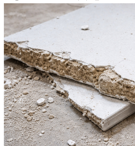
Abgebrochenen Rigipsplatte, Bild wurde mithilfe von AI erstellt
