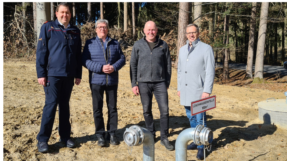
Im Einsatzgebiet der FF Selker-Neustadt wurde in Netzberg bereits ein neuer 100-m³-Löschwasserbehälter errichtet. Heuer folgt die Errichtung eines weiteren Löschwasserbehälters in Kriechmayrdorf. | Foto: Stadtgemeinde
