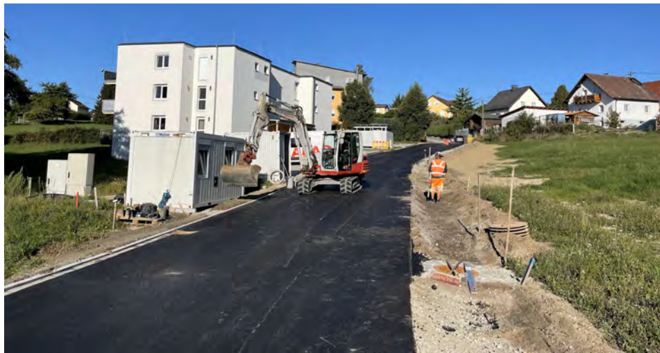
Asphaltierungsarbeiten in Sandleiten
