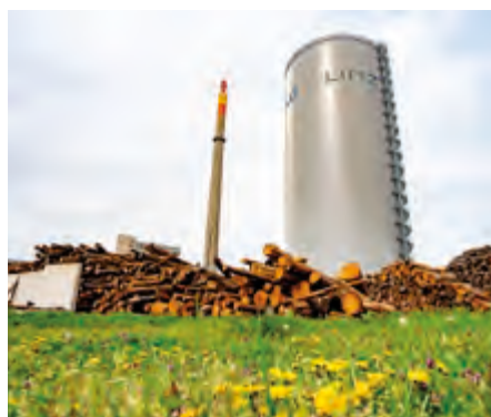
Das große Holzlager am Gelände des Fernheizkraftwerks Linz-Mitte bietet den Rückhalt für die umweltfreundliche Wärmeversorgung in Haid.
