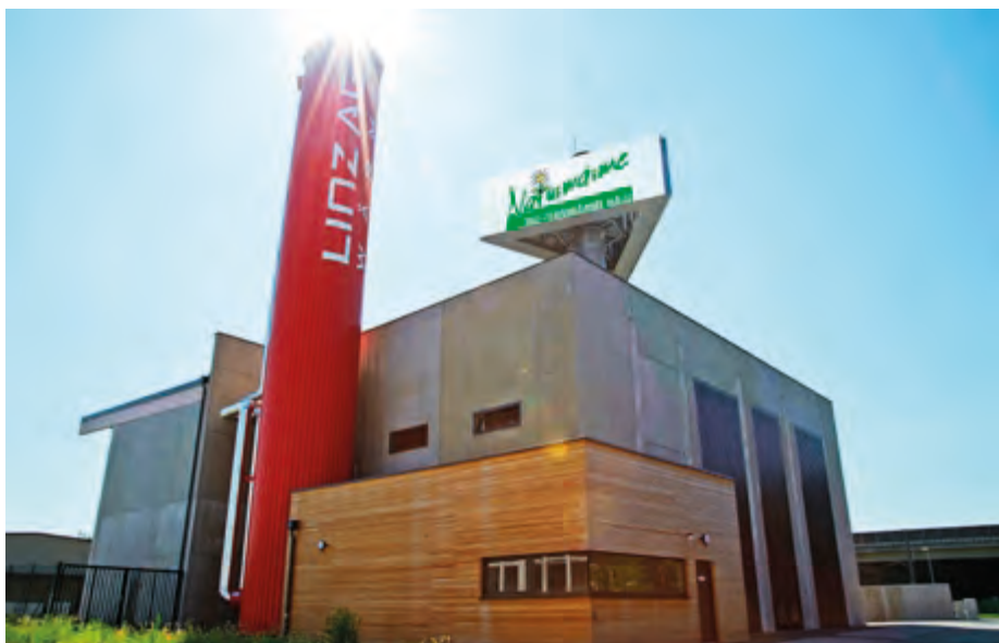
Seit 14 Jahren versorgt das Biomasse-Heizwerk Tausende Wohnungen in Haid.
