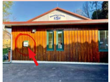
An der Außenwand des Vereinsgebäudes des ESV Entschendorf
