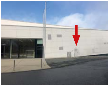
Hügellandhalle – im Bereich der WC-Anlage
