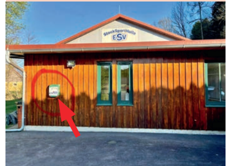
An der Außenwand des Vereinsgebäudes des ESV Entschenndorf
