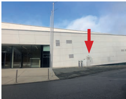
Hügellandhalle – im Bereich der WC-Anlage
