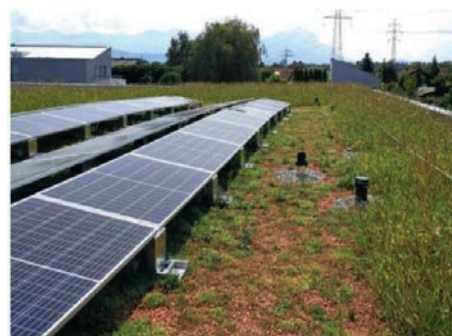
Abbildung 1: Beispielprojekt begrüntes Flachdach mit PV, Kindergarten Ried, Kolbach
