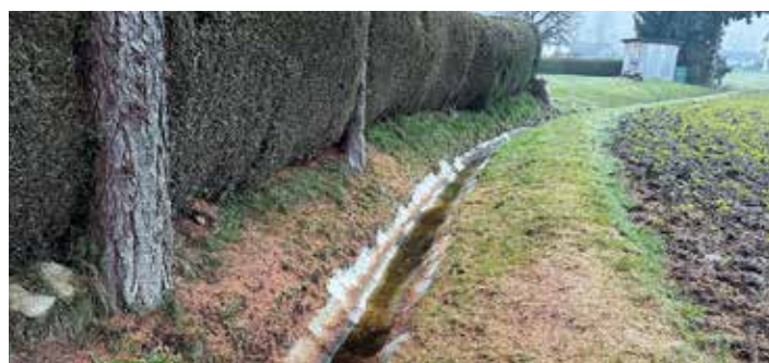
Sanierung des Gerinnes der Gamsbachsiedlung
