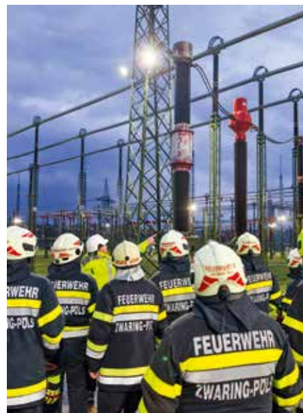
Das Umspannwerk stellt im Einsatzfall eine besondere Herausforderung dar
