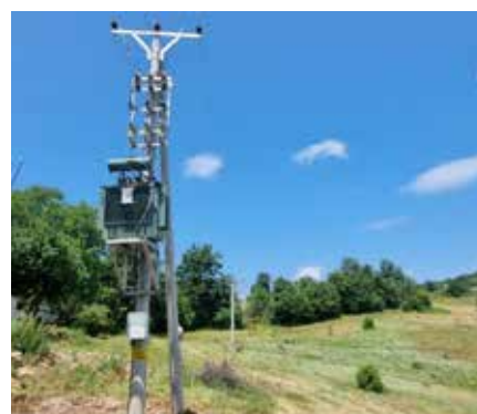
neue Leitung in Arbeit
