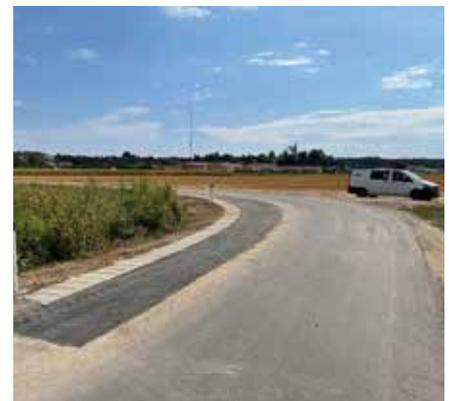
der Petzendorferstraße in Muttendorf, wurden die Innenbereiche der Kurvenbögen saniert. Diese Bereiche wurden mit Betonpflastersteinen ausgelegt um eine möglichst lange Lebensdauer gewährleisten zu können.
