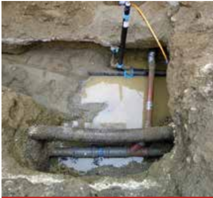
Viele bestehende Einbauten und vorhandenes Grundwasser erschweren den Bauablauf
