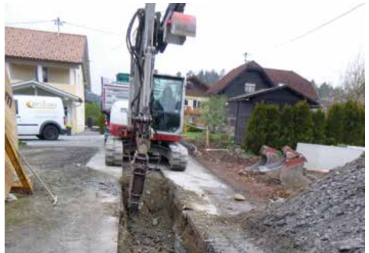
Massiver Fels wird mühevoll abgetragen
