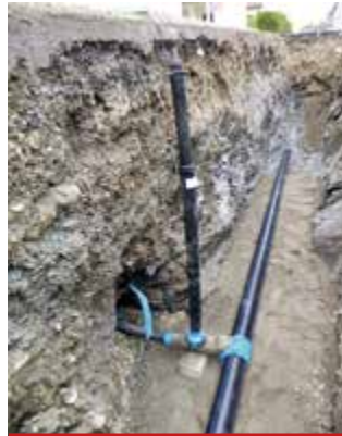
Die neue PE100RC DN 110 PN 10 Leitung wird verlegt
