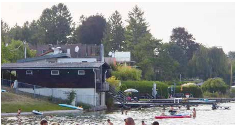
→ Geräumt: der seit 2011 bestehende ÖWR-Stützpunkt am Ufer des Neufelder Sees
