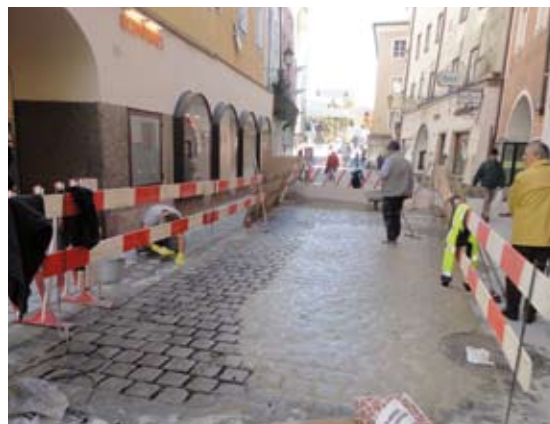
Bauarbeiten in der Thunstraße.
