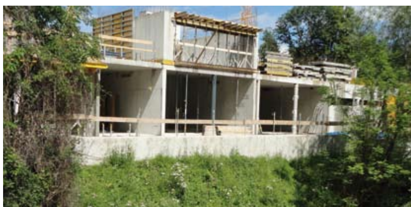
Der Hochwasserschutz bei der Baustelle des neuen Seniorenwohnhauses.
