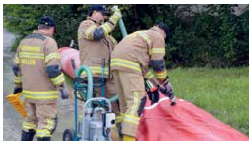
Im Bild Mitglieder der Freiwilligen Feuerwehr der Stadt Hallein bei der Errichtung eines Schutzdeiches mit den neuen „Floodtubes“. Bild: FF
