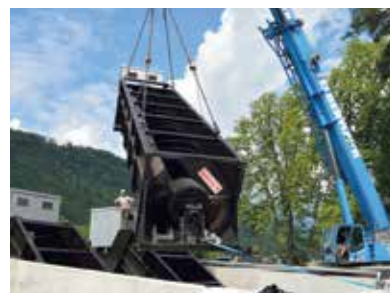
Einsetzen der Schneckenpumpen. Bild: STGM
