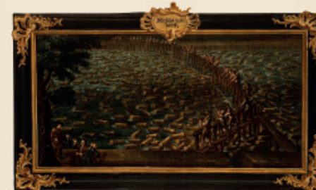
Das Trifthalz wird unter Aufsicht des Griesmeisters von etlichen Arbeitern in die Triftkanäle geleitet.
