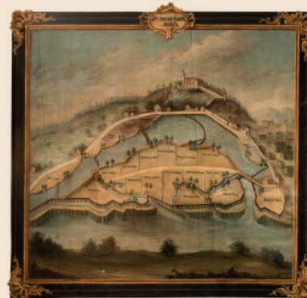
Der Holzrechen in Hallein galt als größte Holzauffanganlage Europas.
