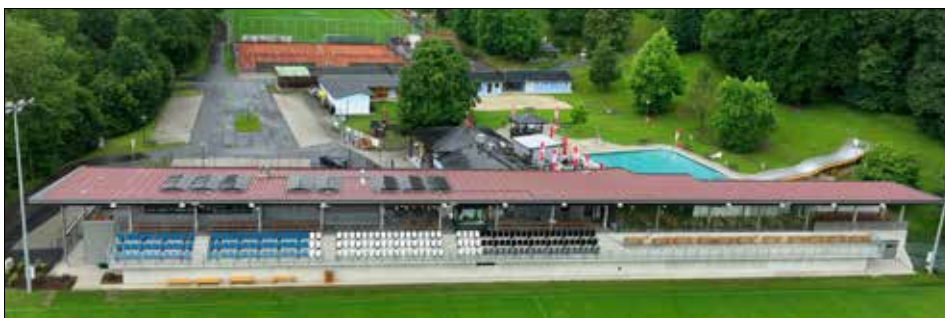
Die neue Sportanlage in St. Peter am Ottersbach wurde im Frühjahr 2026 fertig gestellt (c) steierfoto.at
