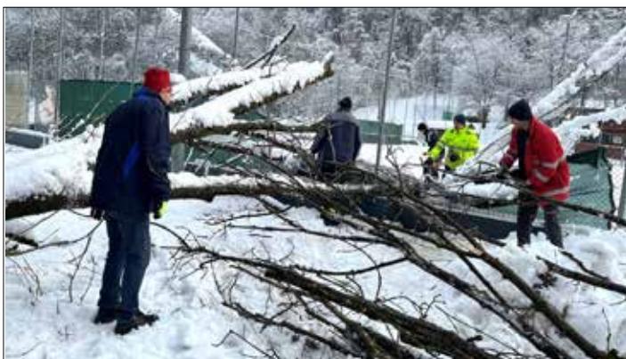
Aufräumarbeiten nach dem Schneebruch beim Tennisplatz
