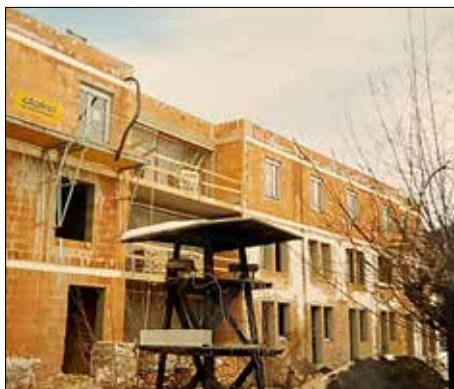
Dank an Familie Gerhold für die zur Verfügung gestellten Baustellenfotos
