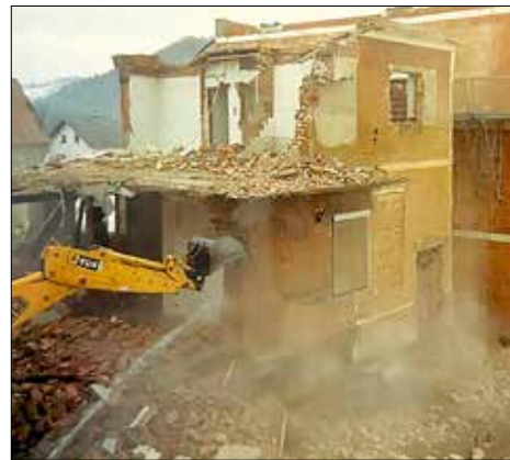
Abriss des ehemaligen „Pauerhauses“
