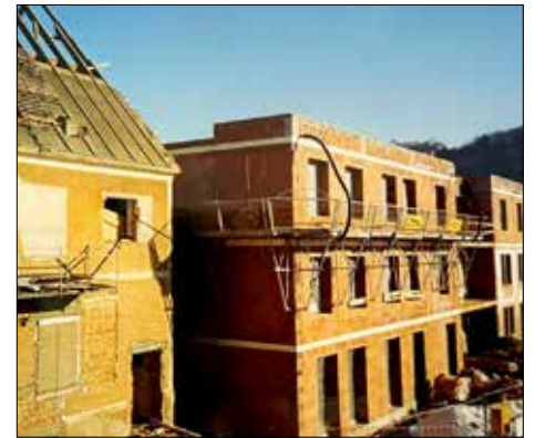
Sicht auf die große Baustelle vom Anwesen der Familie Gerhold aus
