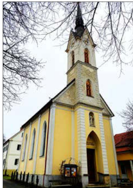
Kirchenrenovierung in Dietersdorf am Gnasbach
