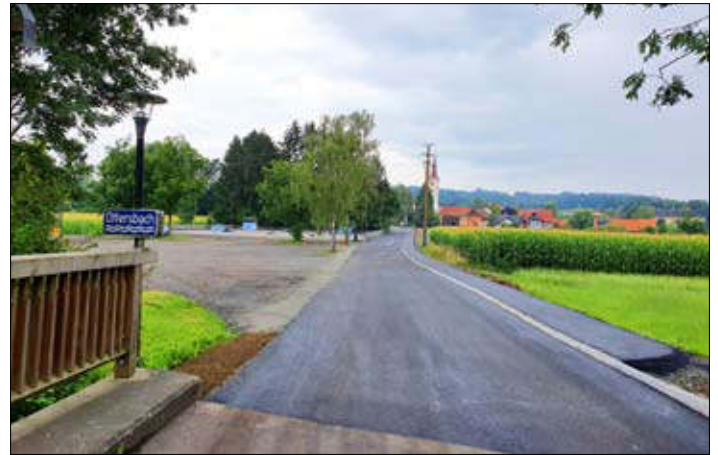
Auch der Badweg zur Freizeitanlage wurde umfassend saniert
