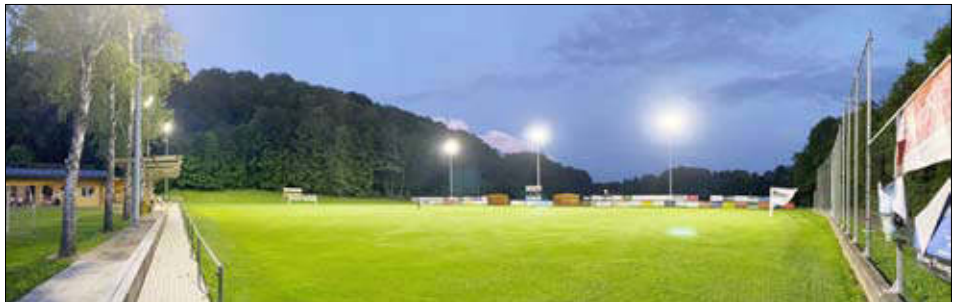
Beim Sportplatz in St. Peter am Ottersbach wurde eine neue Flutlichtanlage installiert
