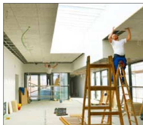
Bauarbeiten beim neuen Schulzentrum
