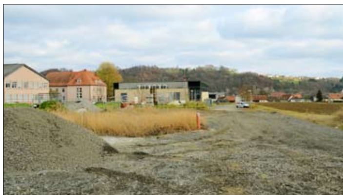
Neue Umfahrung des Schulzentrums in Richtung Rosenbergstraße
