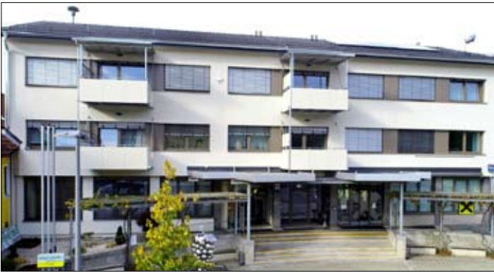
Das ehemalige Amtshaus am Petersplatz wurde umfassend saniert
