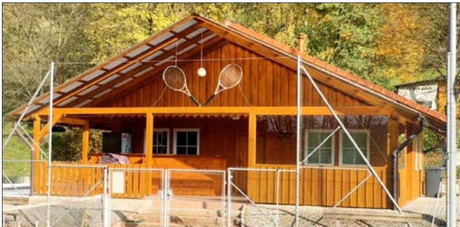
Clubhaus des Tennisclubs St. Peter am Ottersbach nach der umfangreichen Sanierung
