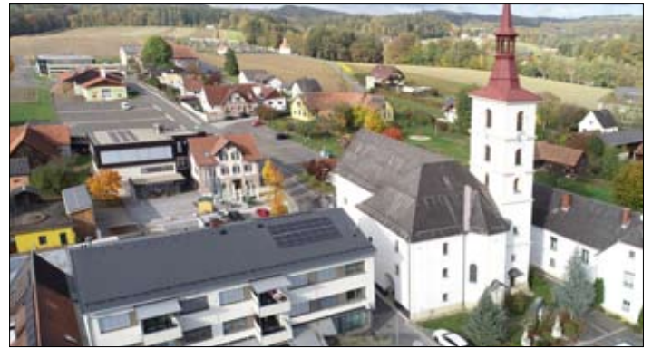
Über Jahre hinweg wurde Schritt für Schritt das Ortszentrum saniert
