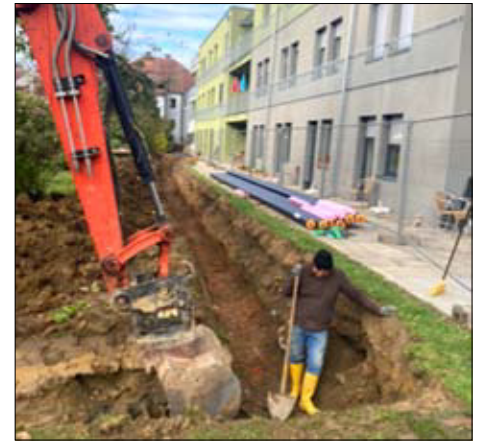
Erweiterung des Nahwärmenetzes im Ort
