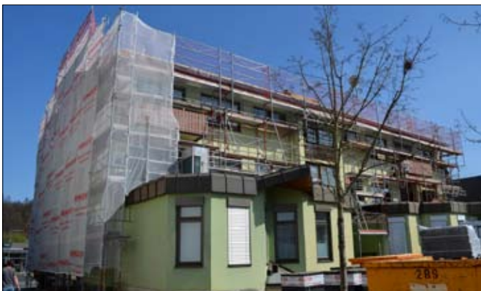
Das ehemalige Amtsgebäude im Ortszentrum wurde umfassend saniert
