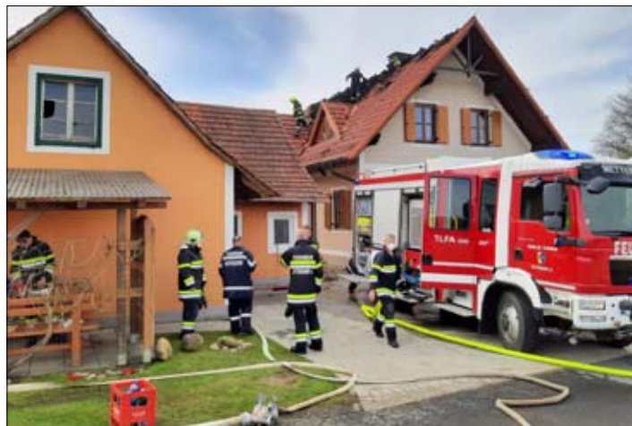
Dachstuhlbrand eines Wohnhauses in Rohrbach am Rosenberg
