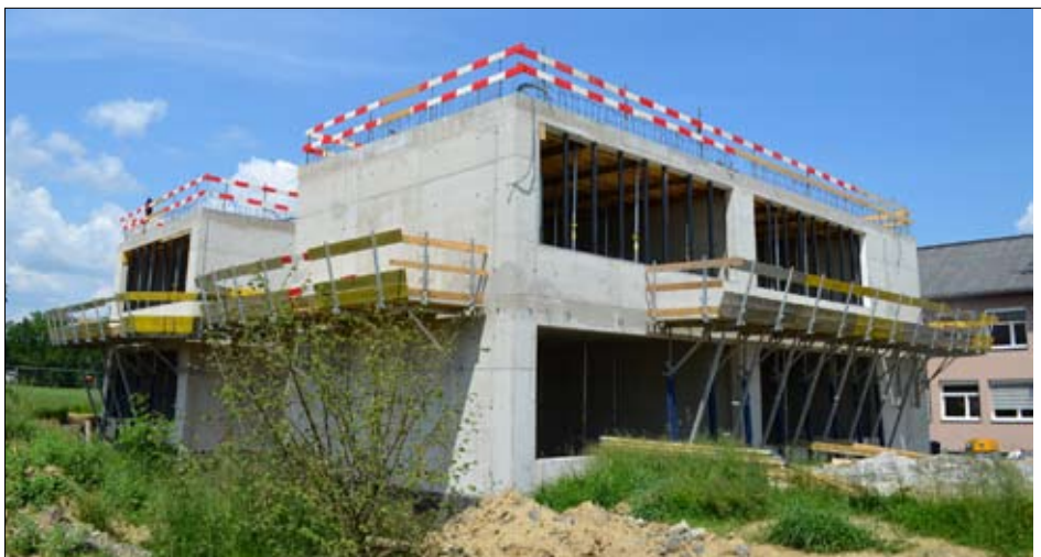
Verlegung der Volksschule St. Peter am Ottersbach zur bestehenden Mittelschule
