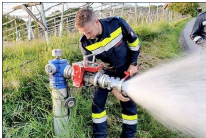
Das Hydrantennetz wird überprüft - die Einsatzbereitschaft wird getestet
