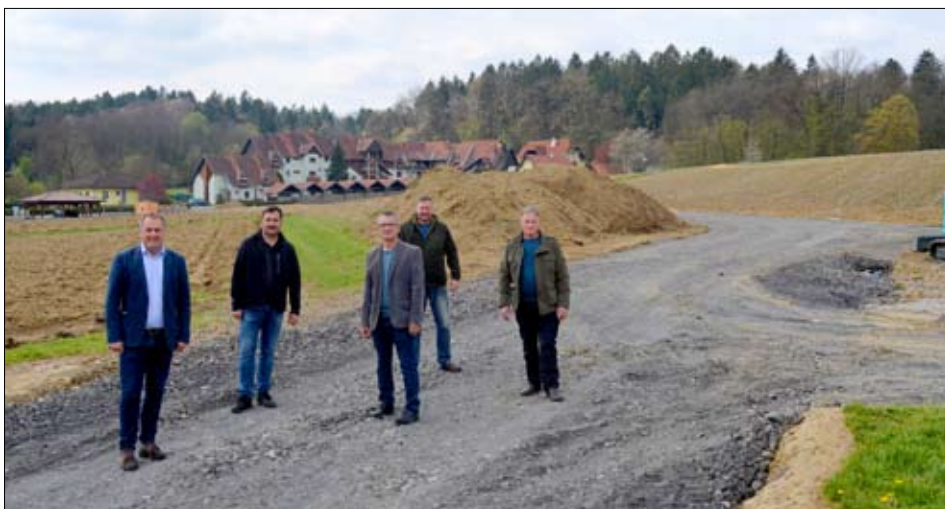
Mit den Bauarbeiten des neuen Schulzentrums in St. Peter am Ottersbach wurde begonnen
