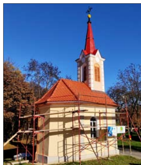
Ein neues Dach für die „Kogelstefflkapelle“
