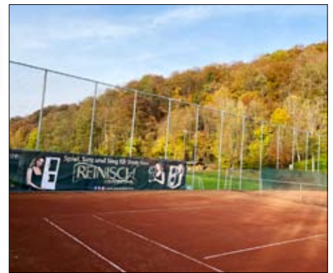
Komplettsanierung - neu errichteter Zaun
