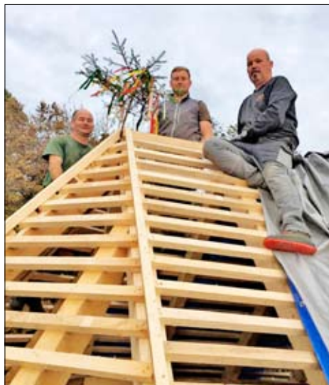
Der Dachstuhl wurde komplett erneuert
