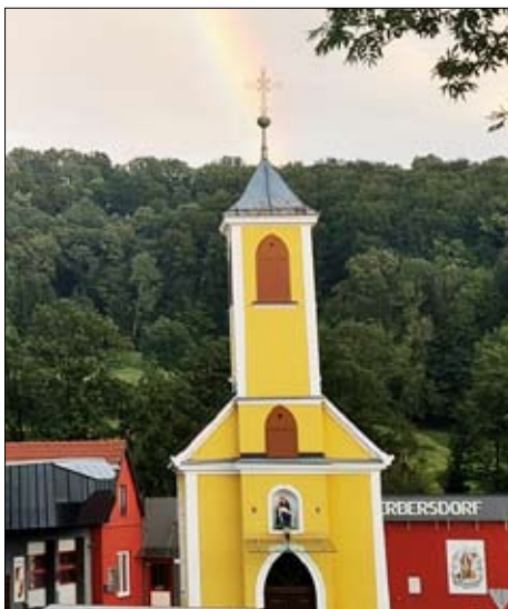
Kapellensanierung in Perbersdorf bei St. Peter
