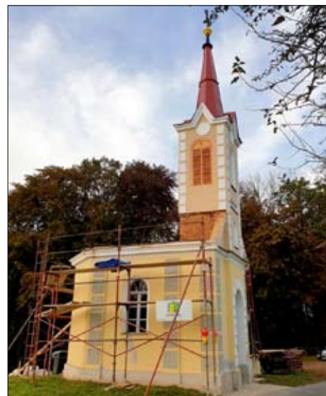
Komplettsanierung der „Kogelstefflkapelle“
