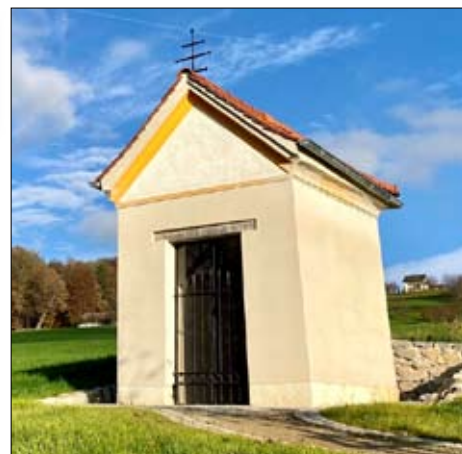
Renovierung der nahen Pölzl Kapelle
