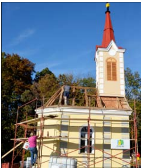
Das alte Kapellendach wurde abgedeckt
