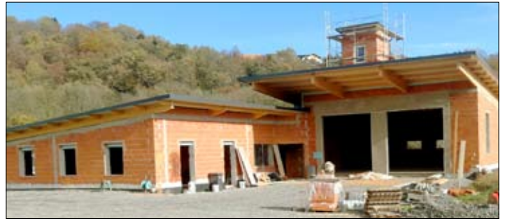
Rohbau des neuen Rüsthauses von St. Peter am Ottersbach
