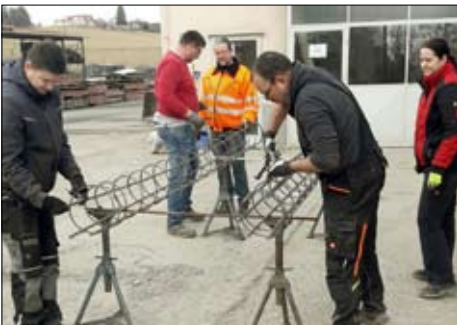
Freiwillige HelferInnen beim Rüsthausbau
