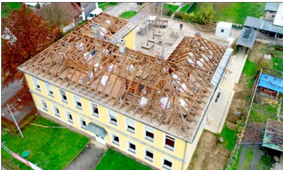
Die Abbrucharbeiten der alten Volksschule haben schon im November 2022 begonnen
